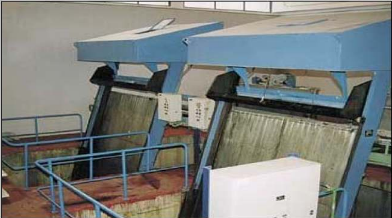
ETE PINEDO (Valencia,Espanha) canal : 2600 x 8000 mm, espazamento 50 mm
