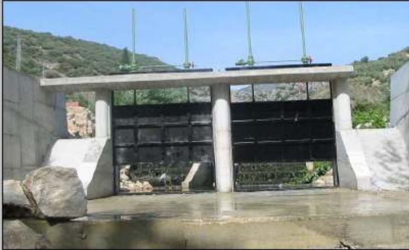
COMPORTAS AÇO CARBONO 4000 X 3000 mm
