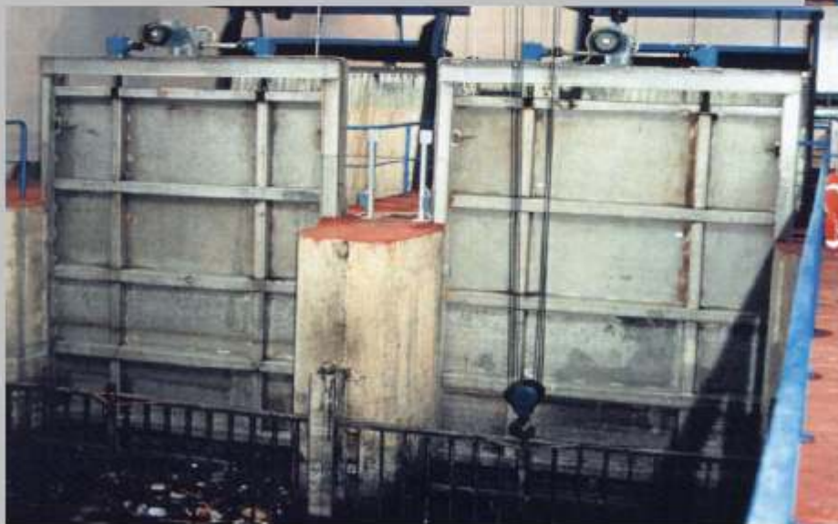
COMPORTAS DE AÇO INOX AISI-316, 2600 X 6500 mm
