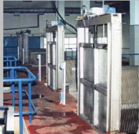
COMPORTAS AÇO INOX AISI-316 1200 X 3000 mm
